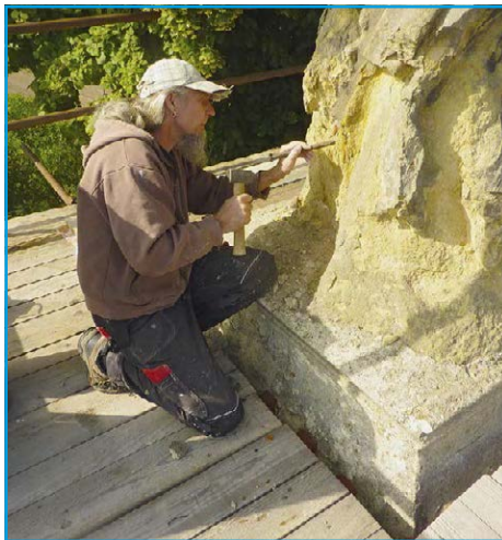
■ Na samotné kapličce probíhaly opravy omítek a střešní krytiny
