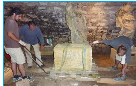
■ Sochy se po podlaze lapidária posunují po dřevěných fošnách
