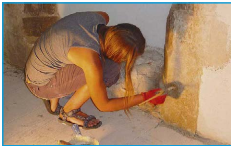
■ V červenci v kostele Narození Panny Marie probíhalo restaurování kamenného ostění původního bočního vstupu
