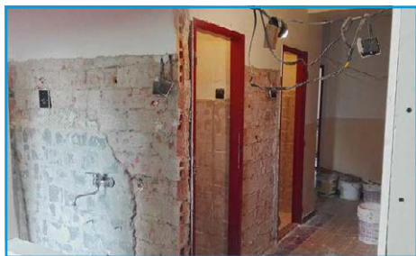
Rekonstrukce sociálního zařízení MŠ Mateřídouška
