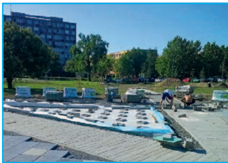
■ Práce na výstavbě City parku pokračují
