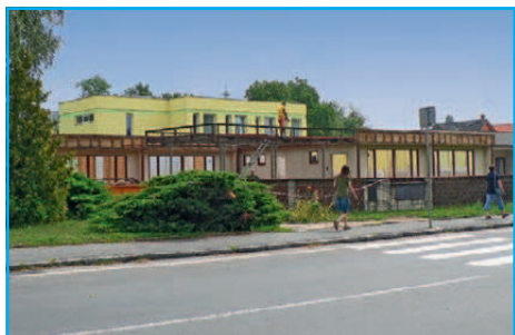
■ Demolice bývalého dětského střediska vedle polikliniky byla zahájena
