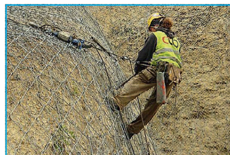
■ Vrtání kotev bylo dokončeno, celkem je jich přes 1000 v délce od 1,5 do 4 m
