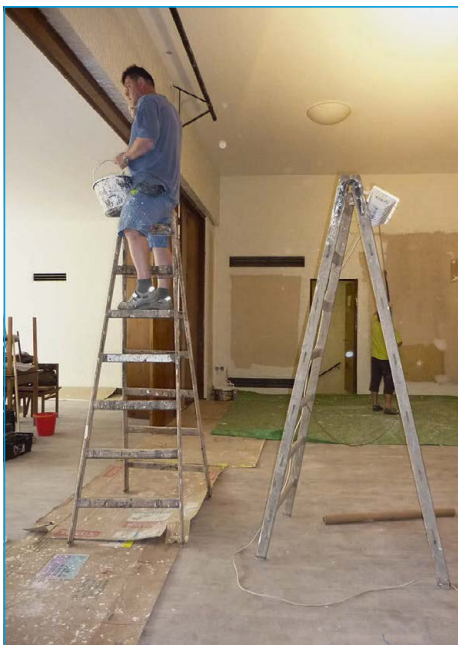
■ Akce „Kulturně vzdělávací centrum Záložna“ je těsně před dokončením
