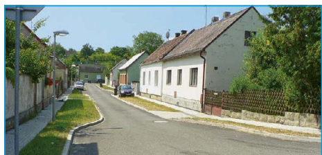
■ Wolkerova ulice - rekonstrukce komunikace dokončena v červnu 2012
