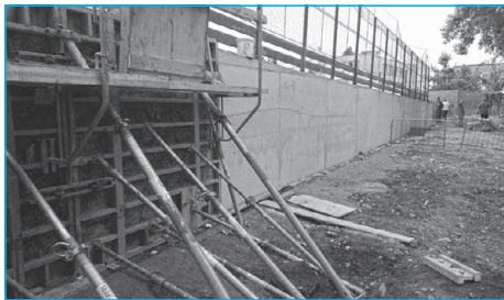
■ Protipovodňová zeď hřiště u ZŠ Pražská
