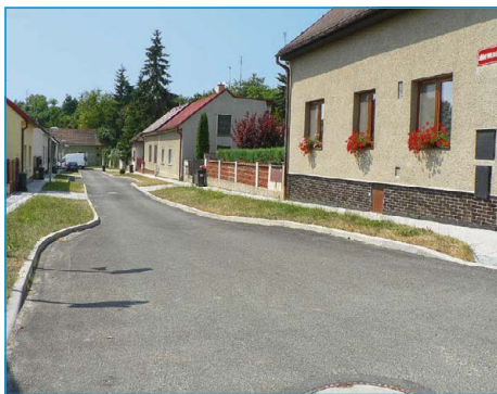
■ Wolkerova ulice - rekonstrukce komunikace probíhala od března do června 2012
