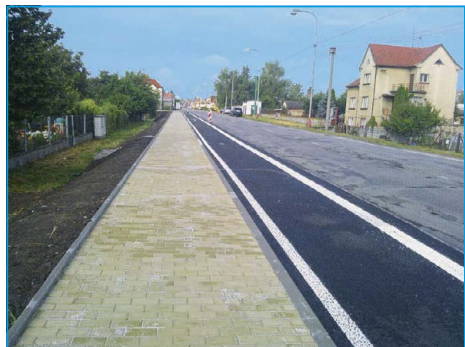
■ Propojení městské části Kbel a ulice Pod Brdy - v červenci byl dokončen celý chodník včetně zaasfaltování pruhu pro cyklisty mezi chodníkem a silnicí
