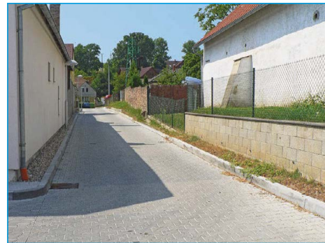
■ Ulice V Zahradách - rekonstrukce komunikace dokončena v srpnu 2012
