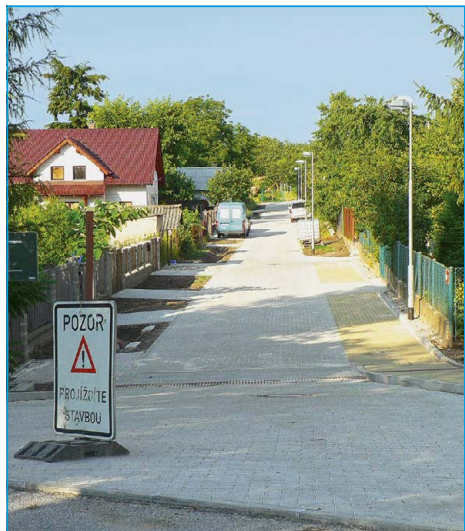
■ Ulice Pod Brdy - pokládka zámkové dlažby byla dokončena
