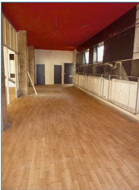
■ Kulturně vzdělávací centrum Záložna – probíhají dokončovací práce
