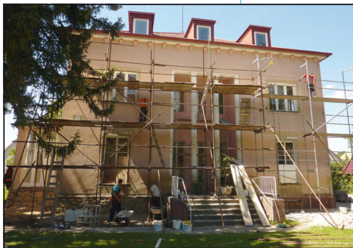
■ Od začátku července probíhá rekonstrukce budovy MŠ Růženka
