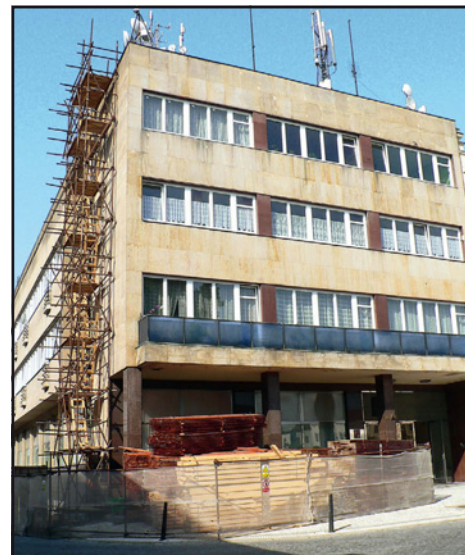
■ Byla zahájena výměna střešního pláště na budově čp. 39, Husovo náměstí
