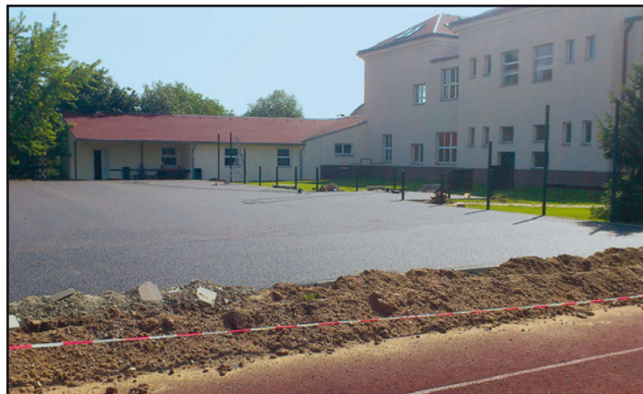
■ V ZŠ Pražská probíhá rekonstrukce hřiště s umělým povrchem
