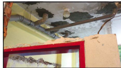
■ Stavební úpravy sociálního zařízení MŠ Poupátko
