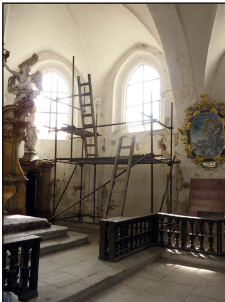
■ Oprava interiéru kostela Narození Panny Marie byla zahájena postavením lešení
