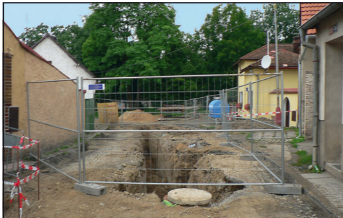
■ Rekonstrukce komunikace v ulici Miroslava Soumara byla zahájena 9. července 2012
