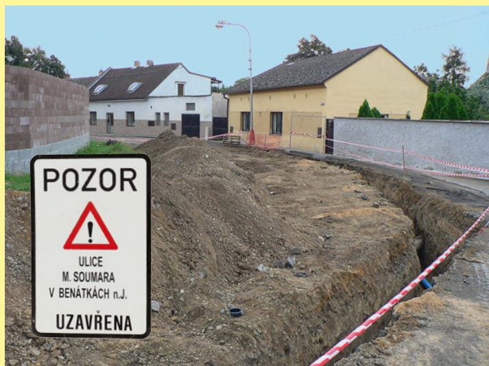
Rekonstrukce komunikace v ulici Miroslava Soumara již byla zahájena...
