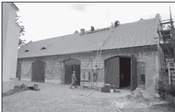
Rekonstrukce kočárovny – je hotov strop v zadní garáži, krov a střešní krytina Fota: MěÚ
