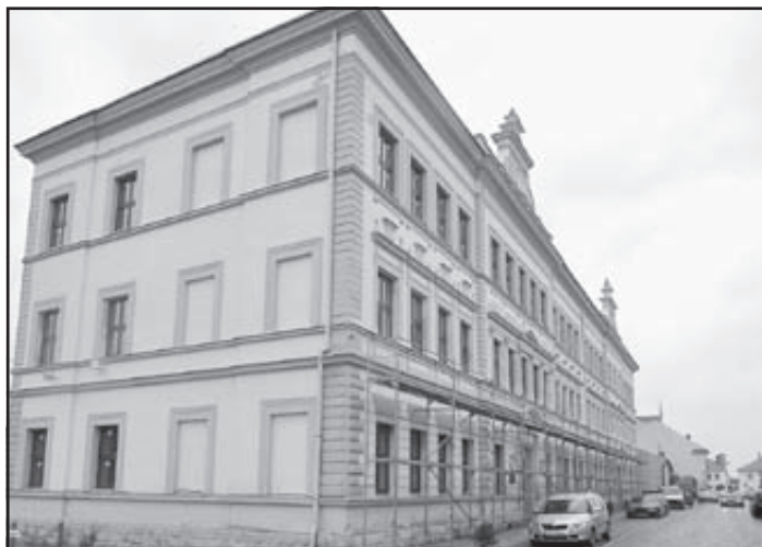
Na budově ZŠ Husovo náměstí probíhá II. etapa výměny oken
