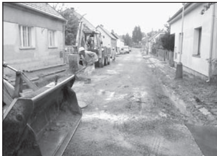
V ulici Wolkerova probíhá výměna cca. 255 bm vodovodního řadu včetně výměny starých vodovodních přípojek
