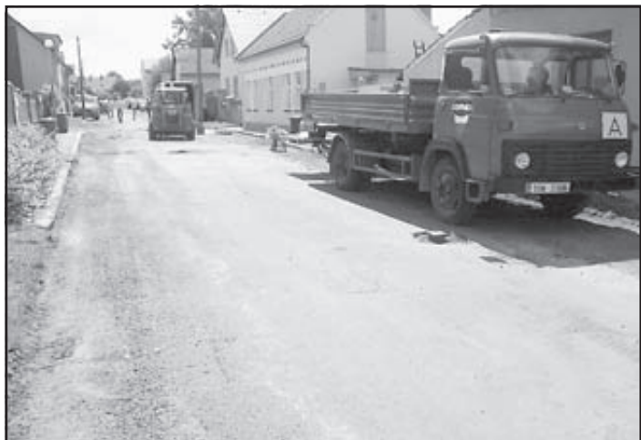
Koncem měsíce června probíhala oprava povrchu komunikace v městské části Kbel
