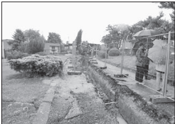
Práce na výměně vodovodu v ulici Nad Remízem (akce Rekonstrukce komunikace v ulici Soukalova)
