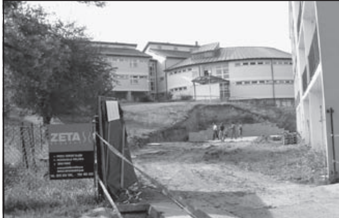
Přístavba společenského sálu k domu MěCKP – v průběhu července bylo zahájeno odtěžování zeminy Foto: emje
