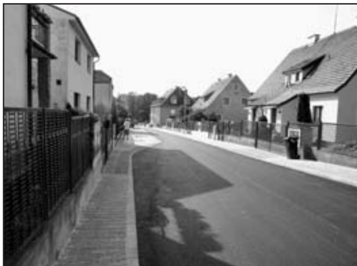
Na konci měsíce června byla dokončena I. etapa rekonstrukce komunikace v ulici Soukalova – o rekonstrukci usilovali obyvatelé Soukalovy ulice řadu let Foto: MěÚ
