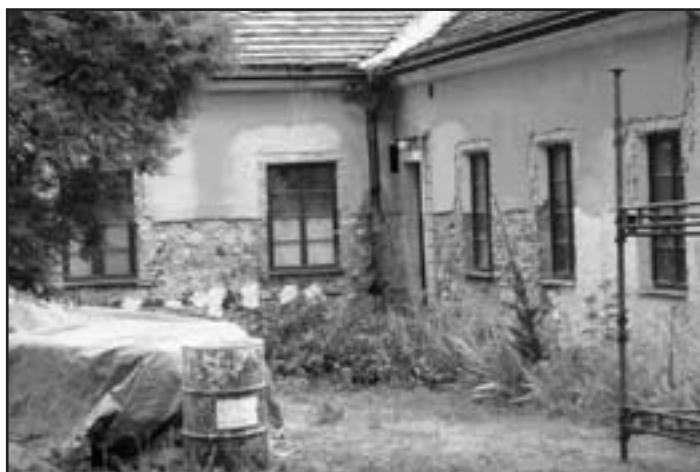
Oprava domu čp. 50 - na fasádě domu byly odstraněny poškozené spodní části omítek
