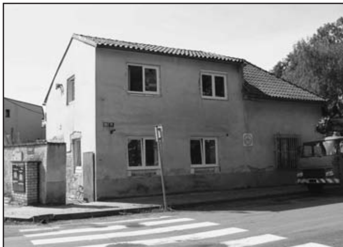
Stavební úpravy domu č.p. 96 v ulici Pražská - během měsíce července byla na stavbě uvnitř objektu vyměněna okna, odstraněna narušená omítka, podlahové krytiny...
