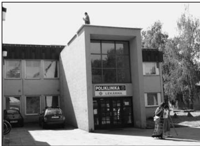
Zateplení polikliniky - v průběhu měsíce července se postupně odstraňovaly staré střešní vrstvy
