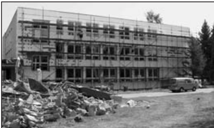
V průběhu měsíce července se postupně vyměnila všechna okna včetně parapetů
