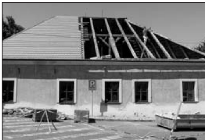
Výměna střešní krytiny na budově školní družiny ZŠ Husovo náměstí
