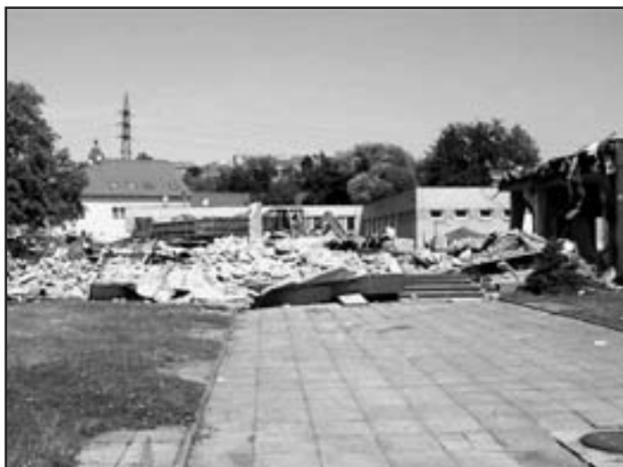
Firma začala s úpravami ploch a odstraňováním dřevin, pokračovala demolicí části šaten
