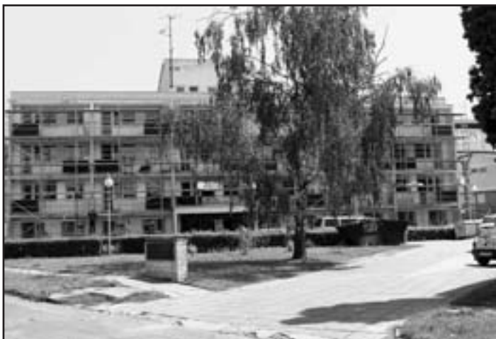
V průběhu měsíce července byla postupně vyměněna všechna okna včetně parapetů na čelní straně a bocích budovy Městského centra komplexní péče. V posledním týdnu měsíce začala firma se zateplováním fasády.
