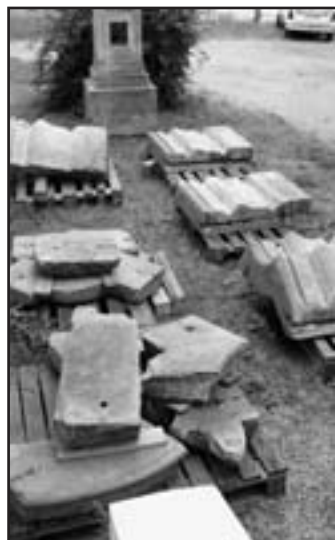
Jednotlivé segmenty kašny byly rozebrány a uloženy na palety
