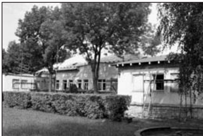
V budově MŠ Jizerka probíhá rekonstrukce střechy, výměna oken a zateplení fasády. Foto Martin Ječný.
