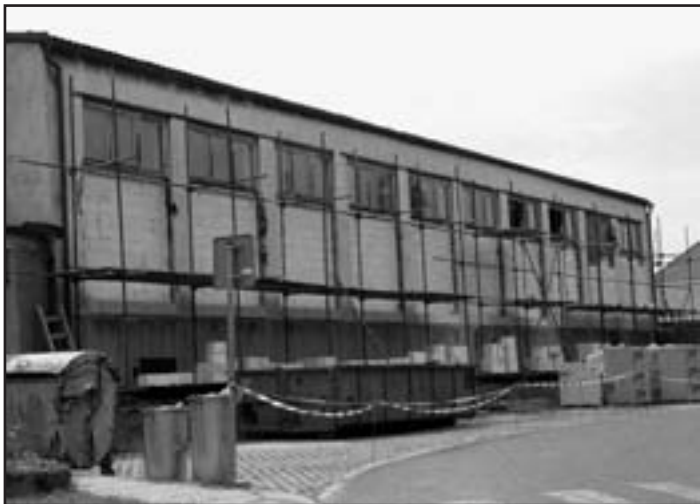
Původní luxférové výplně na severní straně sportovní haly byly odstraněny Foto: Martin Ječný
