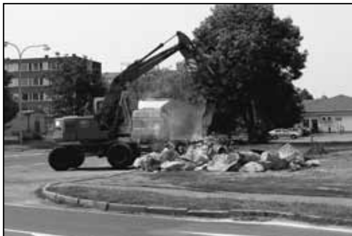
Odstraňování „zarážedla“ na železniční vlečce
