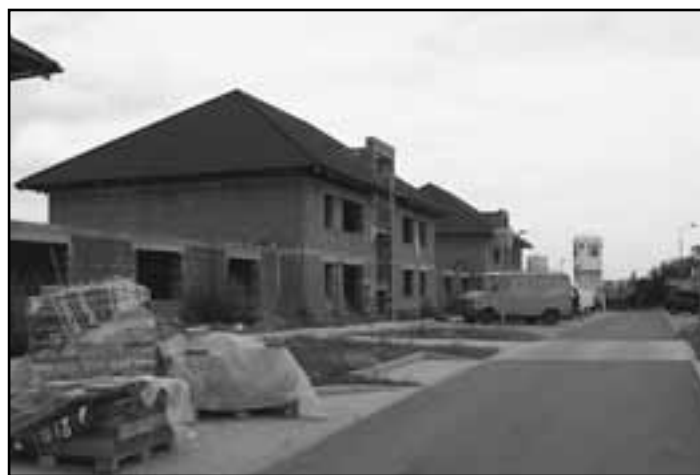
Výstavba bytových domů Nad Vinicemi pokračuje
