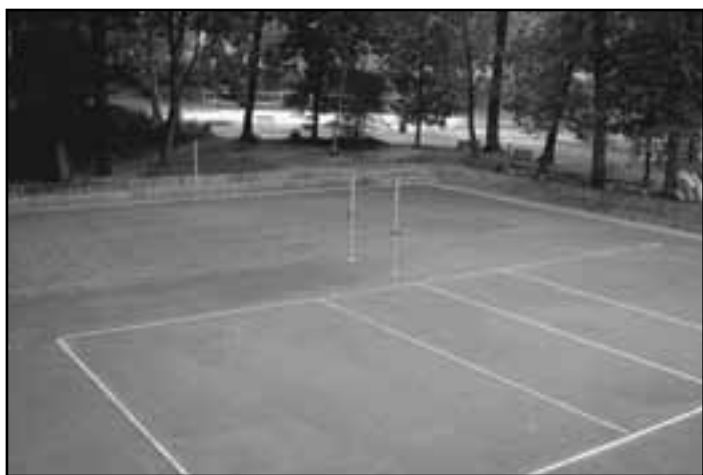
Rekonstrukce volejbalových kurtů je dokončena
