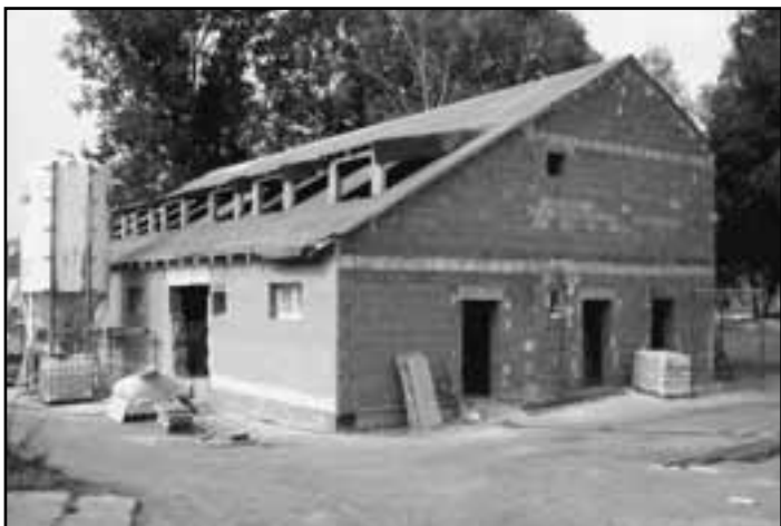
Přístavba šaten na letním stadionu
