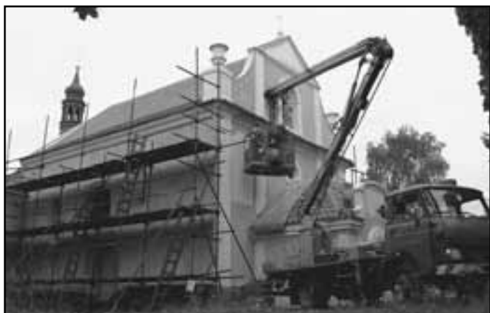
Kostel sv. Martina v Dražičích – dokončuje se oprava vnějšího pláště
