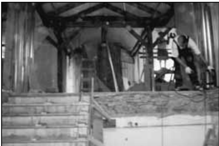
Půdní vestavba v ZŠ Pražská
