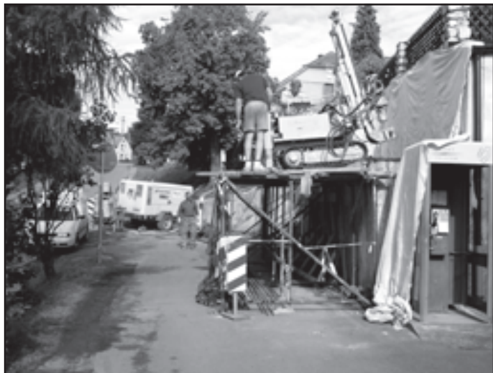
Začala oprava opěrné zdi v ulici Kordinů.
