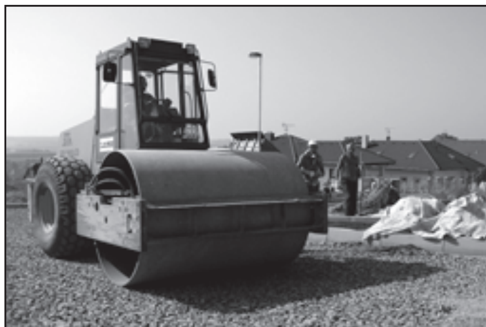
V lokalitě Nad Vinicemi se nyní pokládají jednotlivé vrstvy komunikací.
