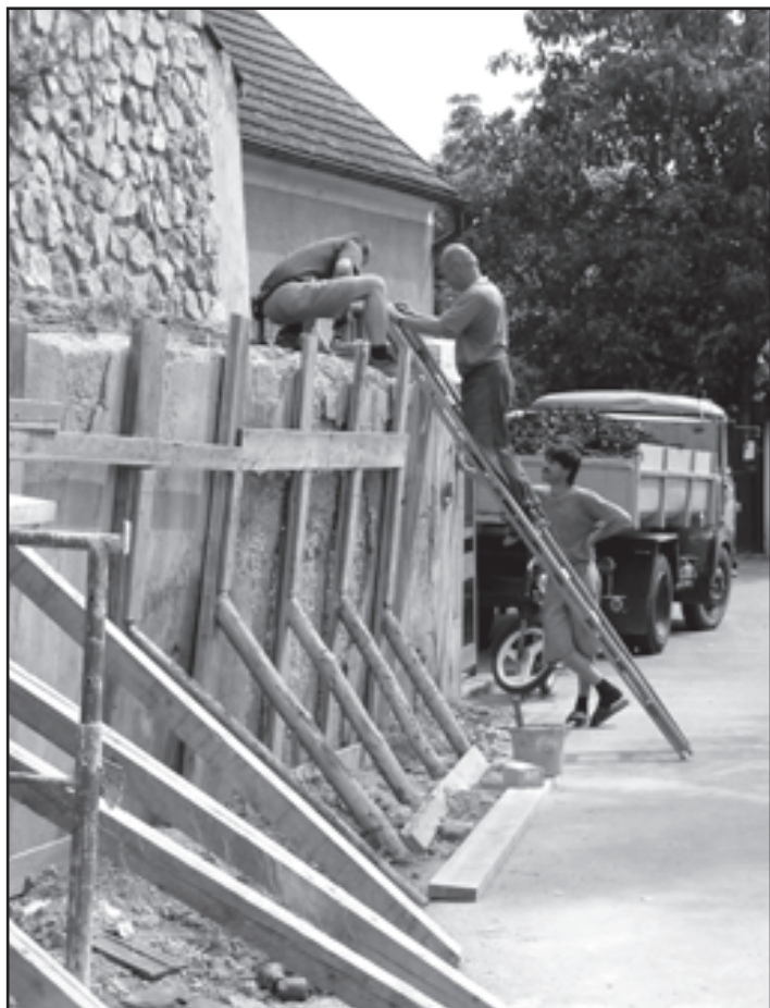
Rekonstrukce opěrné zdi v Mělnické ulici Foto Ing. Alena Kratochvílová
