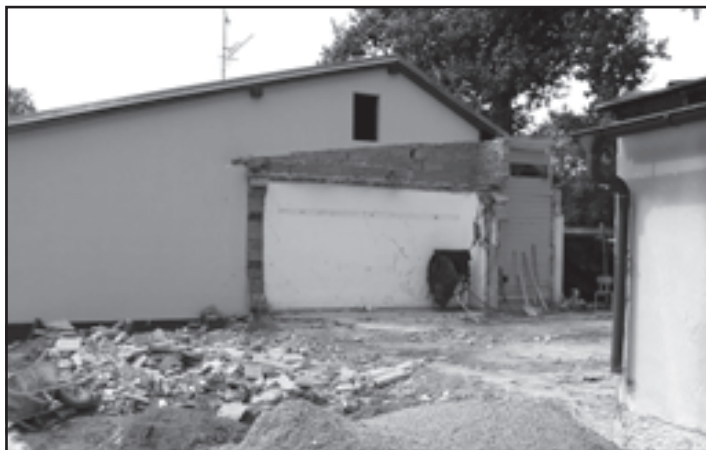
V polovině července začala rekonstrukce šaten a sociálního zařízení na letním stadionu.
