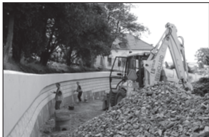
Při rekonstrukci komunikace v Podolecké se opravuje i opěrná zeď při výjezdu do ulice Dražická a Vaněčkova. Foto Ing. Alena Kratochvílová
