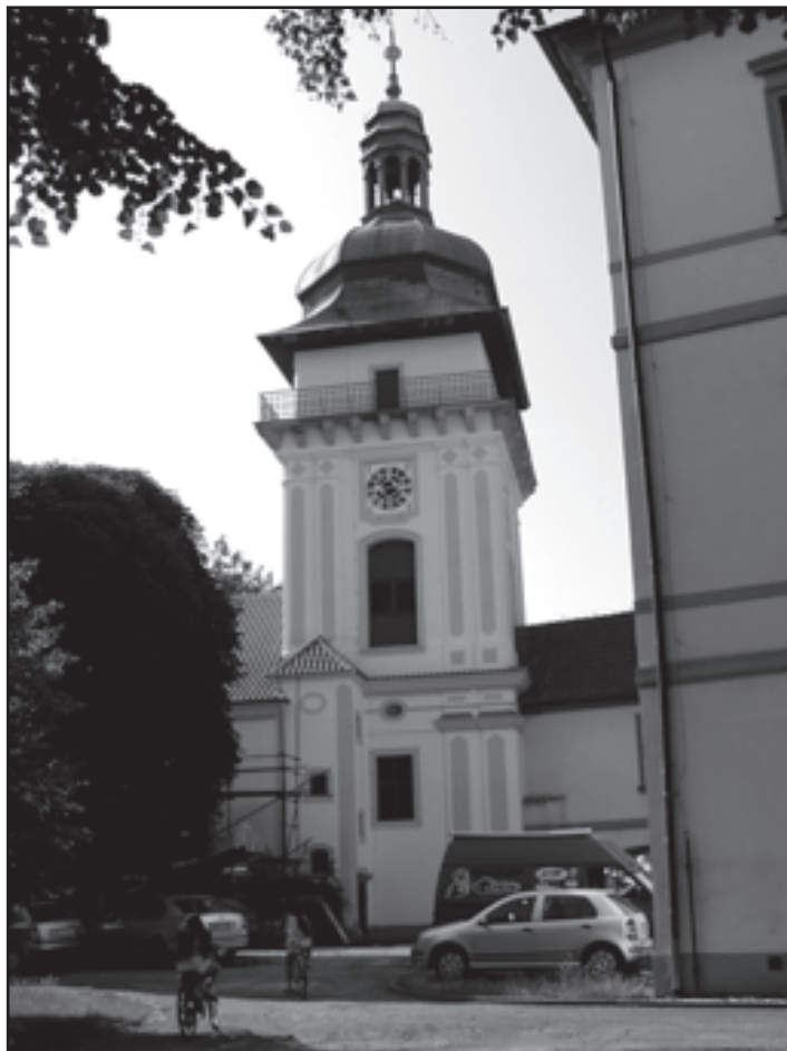
Zámecká věž po letošní opravě
