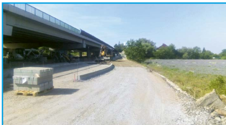
■ Rekonstrukce komunikace II/610 - pokládka nového konstrukčního souvrství u Kbelu
