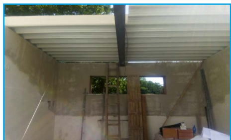
■ Montáž střešních panelů na zimním stadionu
