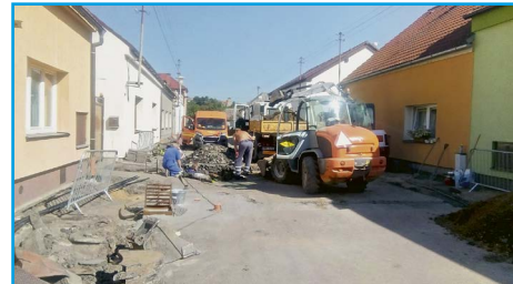
■ V ulici Kalistova probíhá výměna vodovodních přípojek a uzávěrů
