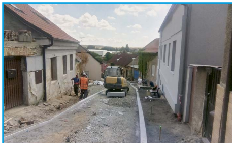
■ V ulici Revoluční probíhá pokládka obrubníků
