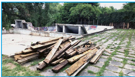
■ Stávající konstrukce skateparku byly odstraněny
