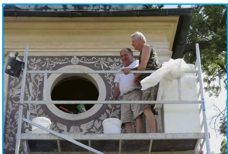
■ Sgrafita na věži byla opravena a natřena
