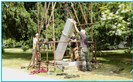
■ Na nový betonový základ byl osazen původní žulový podstavec
