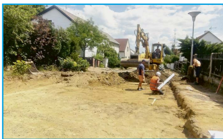
■ V ulici Kvapilova probíhá výměna konstrukčního souvrství
