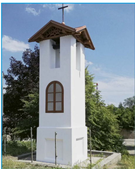
■ Opravená kaplička v Obodři
