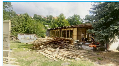
■ Demolice objektu skautské klubovny v areálu MŠ Jizerka
