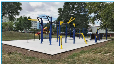
■ Výstavba workoutového hřiště
