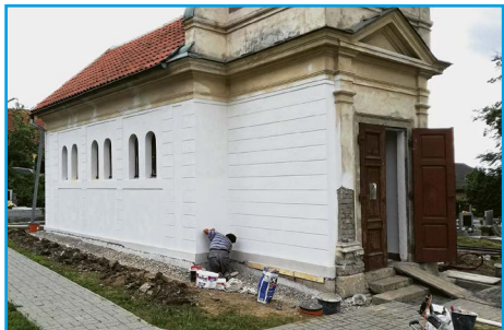
■ Omítky poškozené vlhkostí se nahradily sanačními
