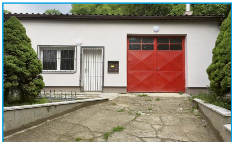
■ Oprava čp. 4 v městské části Dražice je dokončena
