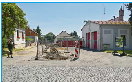
■ V Jiráskově ulici pokračuje výměna vodovodního řadu
