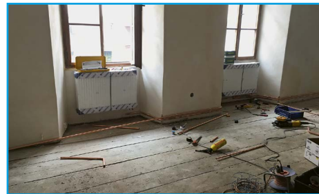
■ V prvním patře byly dokončeny omítky a rozvody topení
