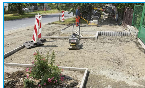
■ Výstavba chodníků a úprava vjezdů v horní části ulice Mladská
