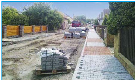
■ V ulici Červíčková probíhá pokládka zámkové dlažby na chodnících
