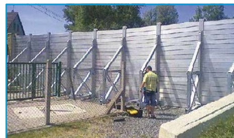
■ Po zalití všech kotev budou postupně shora sítě vypínány
