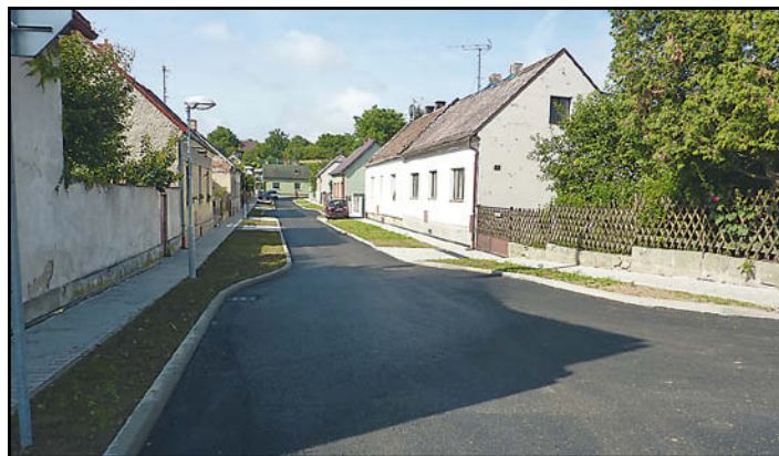
Rekonstrukce komunikace v ulici Jiřího Wolкера byla koncem měsíce června dokončena
