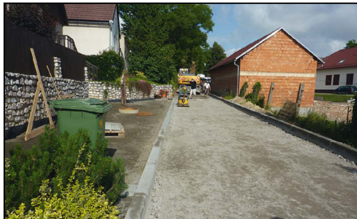
Rekonstrukce komunikace v ulici Obodřecká pokračuje
