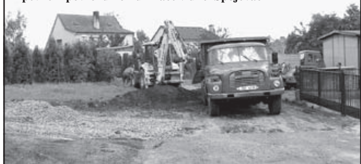
Firma ZETA Benátky s.r.o. zahájila v polovině června práce na opravě povrchu komunikace v části ulice Spojovací v Benátkách nad Jizerou II (foto ze dne 24. června 2011)
