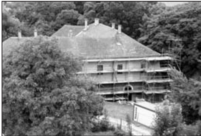
Firma Flavius Praha zahájila opravu domu čp. 50 v zámeckém areálu
