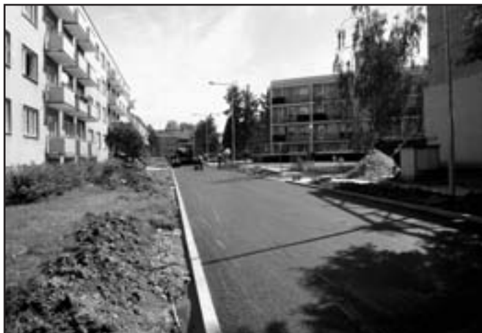
Náměstí 17. listopadu – pokládka nového asfaltového krytu komunikace
