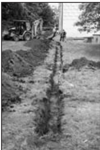
Revitalizace zámeckého parku – pokládka inženýrských sítí
