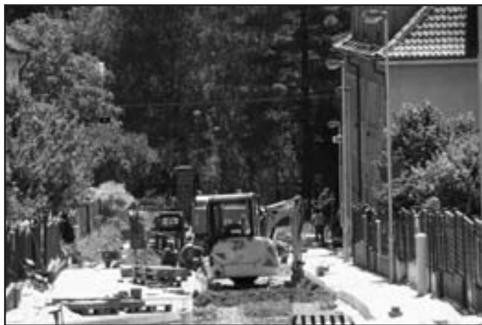
Soukalova ulice – rekonstrukce komunikace
