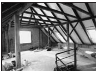
Rekonstrukce a přístavba čp. 432, Žižkova ulice – Na původním objektu rodinného domu byla přeložena střecha a pod taškovou krytinu byla vložena pojistná hydroizolace
