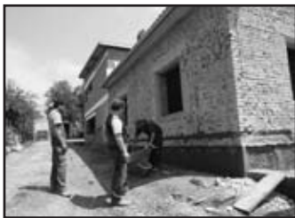
Rekonstrukce a přístavba čp. 432, Žižkova ulice
