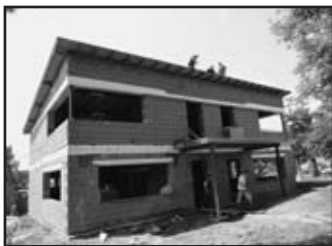
Rekonstrukce a přístavba čp. 432, Žižkova ulice – Na přístavbě byla dokončena pokládka střešní krytiny
