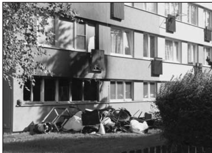
Den po požáru ve sklepních prostorách bytového panelového domu čp. 601, Na Burse
