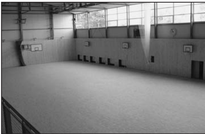
Přístavba tělocvičny k ZŠ Pražská – pokládání palubovky bylo zahájeno ve druhém červnovém týdnu
