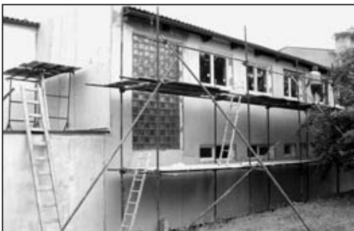
Výměna oken a zateplení zadní strany sportovní haly města Foto: MěÚ
