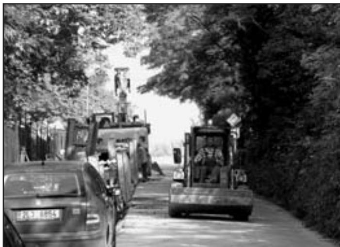
Na Štěpnici v městské části Dražice probíhá pokládka hlavního kanalizačního řadu Foto: MěÚ
