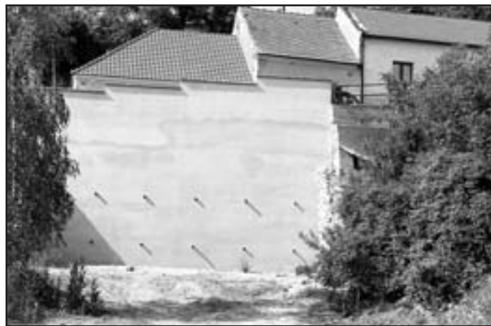
Oprava opěrné zdi ve Smetanově ulici je dokončena
