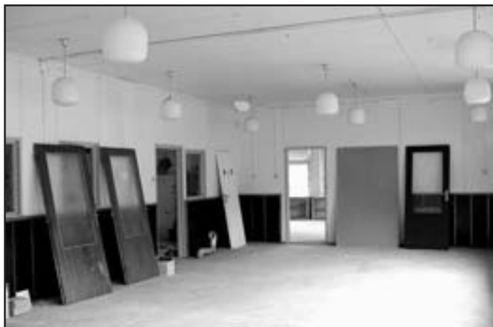
Byly zahájeny stavební úpravy pavilonu v areálu MŠ Jizerka
