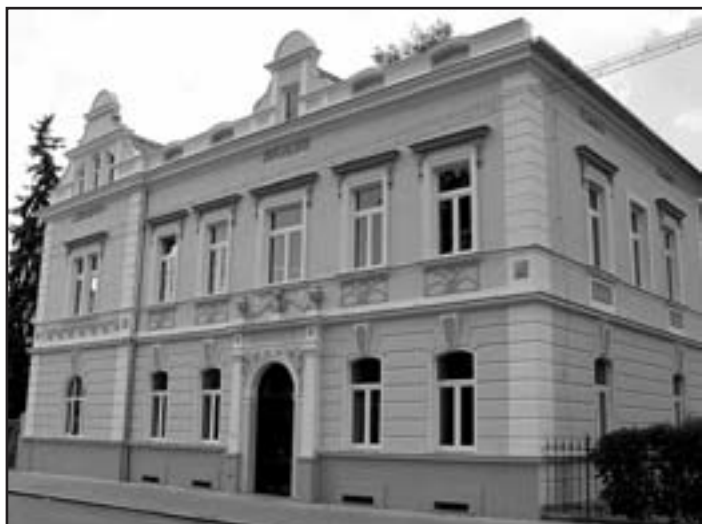
Budova „Staré pošty“ v novém kabátě.
