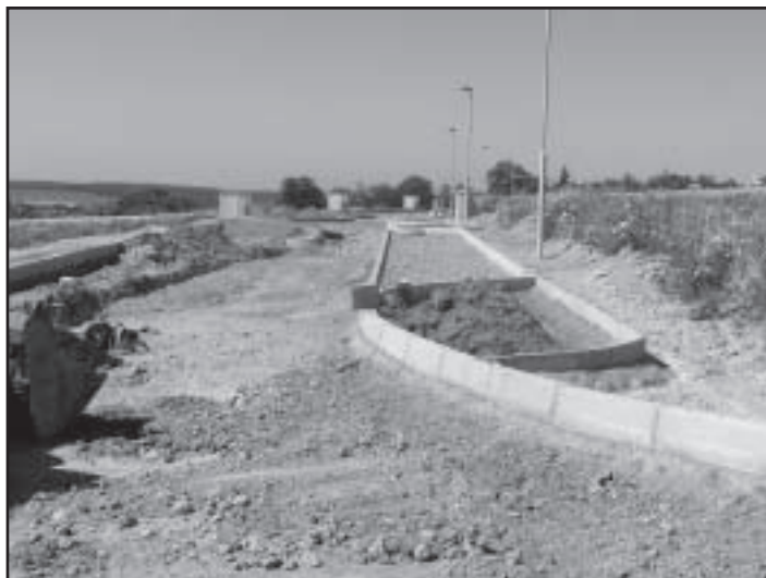
Výstavba inženýrských sítí a komunikací v lokalitě Nad Vinicemi
