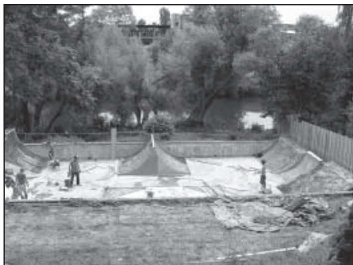
Výstavba nového skateboardového hřiště v prostoru na Urbanovce
