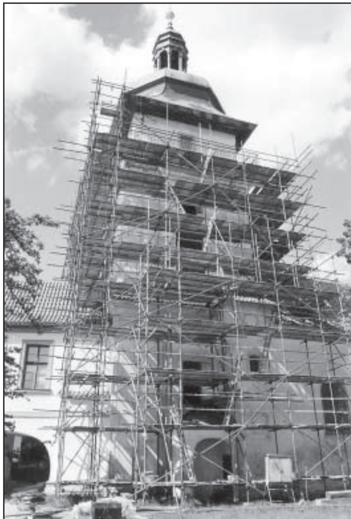
Rozsáhlé lešení předznamenává velkou opravu věže i celého zámekého kostela. Fotografie Jaromír Polák
