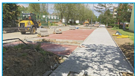
Probíhající práce na Rekonstrukci ulice Platanová koncem měsíce května
