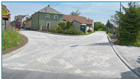
V ulici ve Kbele byly dokončeny opravy povrchů
