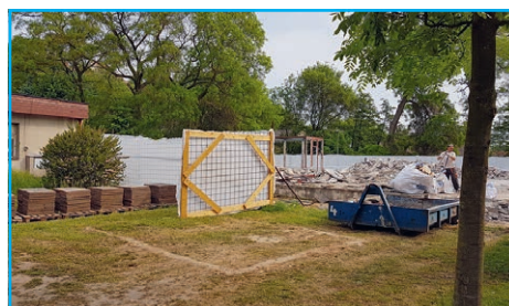
■ V květnu probíhala demolice „tesko“ pavilonu v objektu MŠ Jizerka
