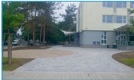
■ Úprava zpevněných ploch u multifunkčního centra v ulici U Cukrovaru
