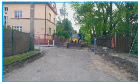
■ Rekonstrukce ulice Raabova
