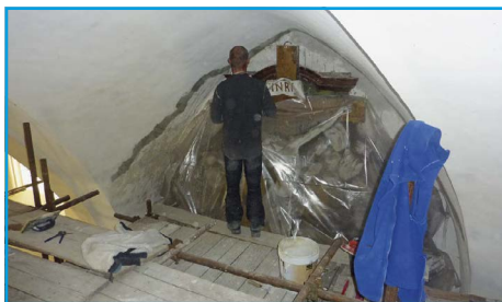
■ V kostele Narození Panny Marie probíhají opravy omítky
