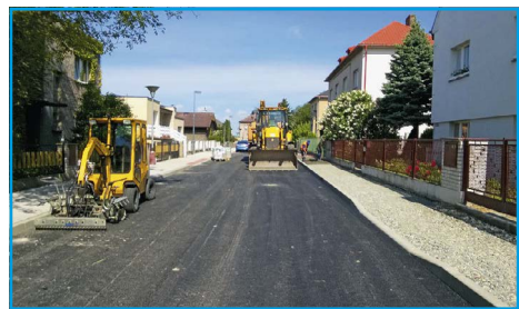
■ V ulici Dr. Nováka byla položena základní vrstva asfaltu
