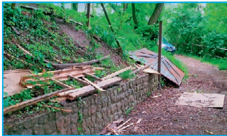
■ V květnu proběhla demontáž vybavení prostoru v bývalém letním kině Vojnarka
