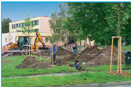
■ City Park – práce na kanalizační přípoje
