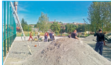
■ Víceúčelové hřiště u Billy - v průběhu měsíce května byla dokončena montáž sloupů oplocení
