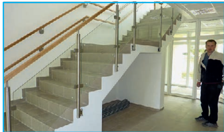
■ Dostavba polikliniky – byly provedeny poslední dokončovací práce
