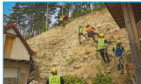
■ Bylo provedeno kompletní očištění skalní stěny
