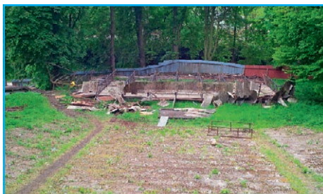
■ V prostoru Vojnarka budou dále odstraňovány a likvidovány betonové základy z hlediště
