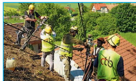
■ Na horní hraně skály byly navrtány kotvy
