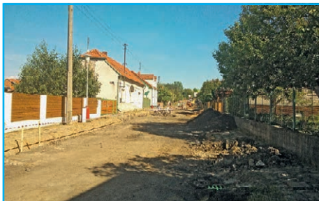
■ V ulici Červíčkova probíhá úprava komunikace
