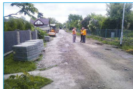
■ V ulici Pod Brdy byla zahájena pokládka zámkové dlažby
