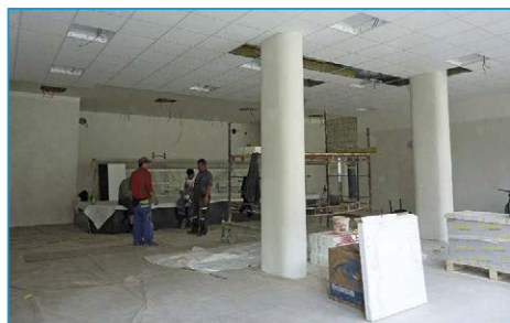
■ Kulturně vzdělávací zařízení Záložna - malý sál: jsou hotovy podhledy s akustickou izolací, osazena svítidla v podhledech
