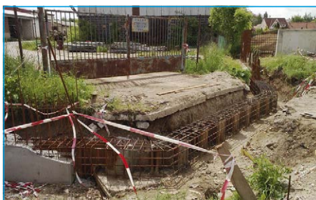
■ Výstavba protipovodňové hráze
