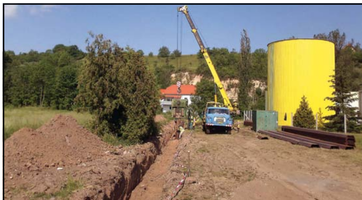
■ Začátkem měsíce května byly zahájeny práce na realizaci protipovodňové ochrany města. Na snímku je vidět práce na zabezpečení podzemní části proti průsakům u ČOV
