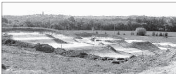
Dokončování vápencového povrchu na dráze ve Kbelu
