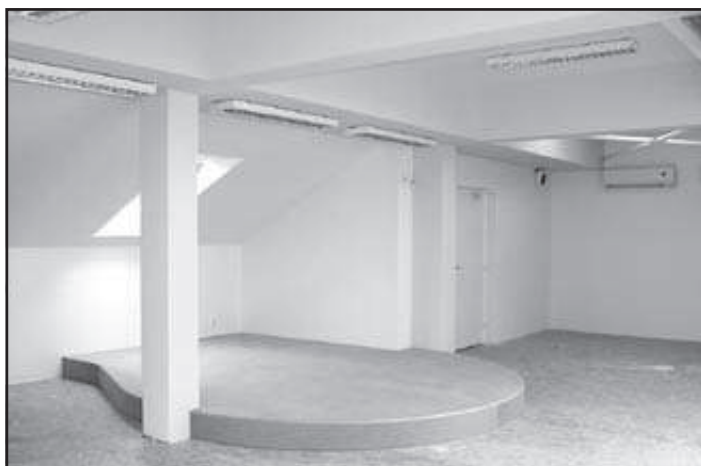
ZŠ Husovo náměstí – půdní vestavba: dokončený stupínek v klubovně
