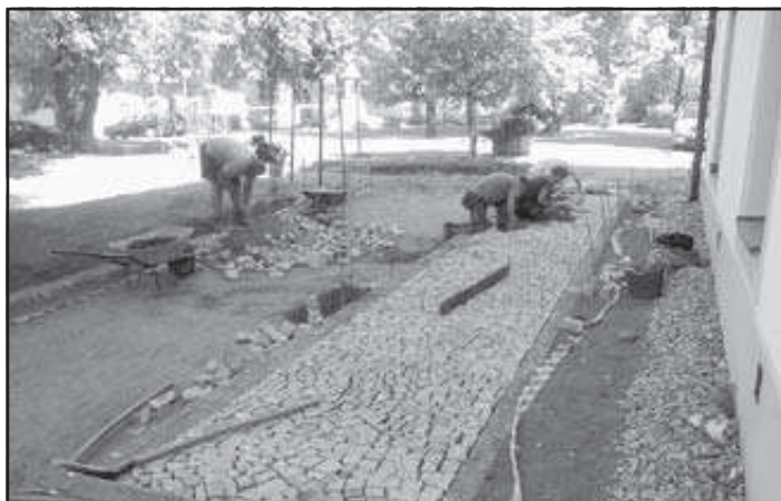
V zámeckém areálu probíhá revitalizace zámeckého parku – II. etapa
