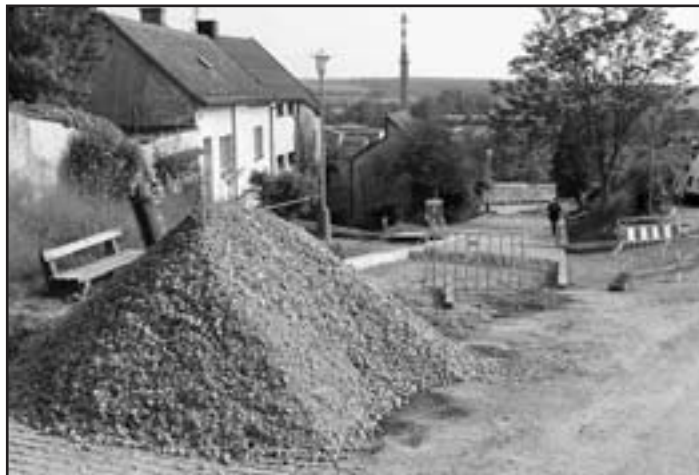
Práce na rekonstrukci komunikace ve Smetanově ulici v části od Tyršovy ulice (vpravo) k Revoluční (vlevo)
