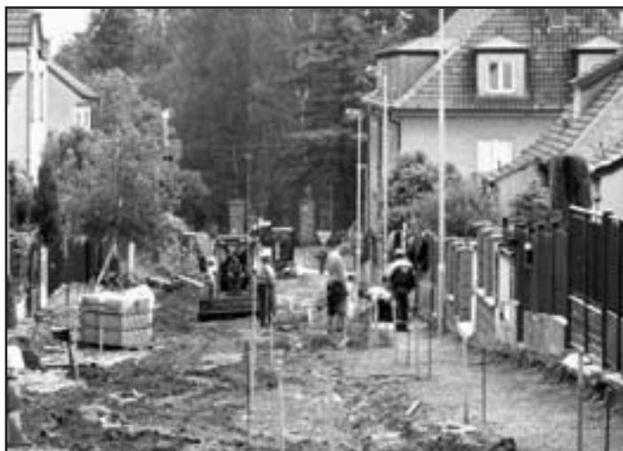
V ulici Soukalova probíhá rekonstrukce
