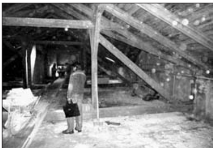
Rekonstrukci a modernizaci půdních prostor ZŠ Husovo náměstí provádí firma GEO-ING Jihlava Foto: MěÚ
