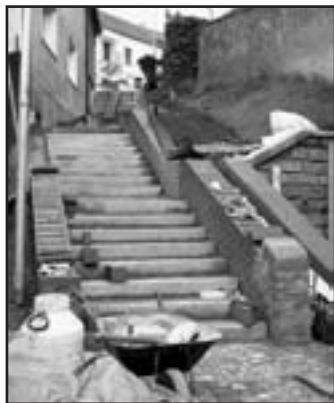
Součástí rekonstrukce Smetanovy ulice je výstavba nových schodů Na Vyhlídce
