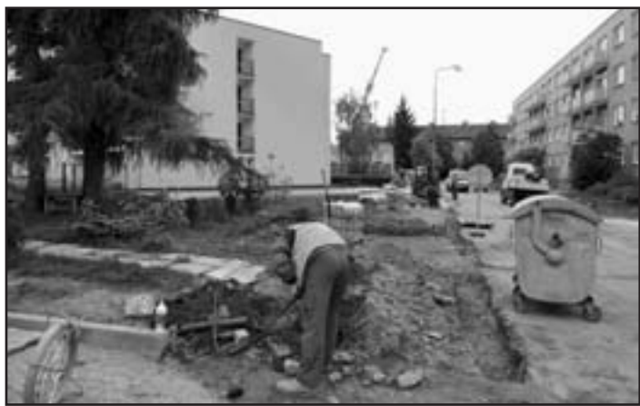
Na náměstí 17. listopadu byly postupně zahájeny práce na terénních úpravách
