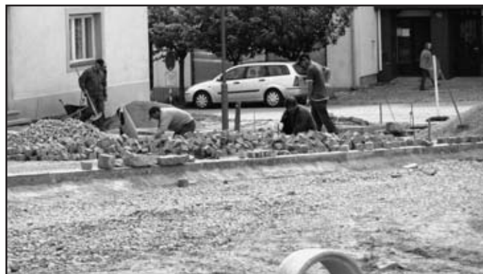
Husovo náměstí – na chodnících se pokládá dlažba z mozaiky z růžového sliveneckého mramoru a černého čediče Foto: MěÚ
