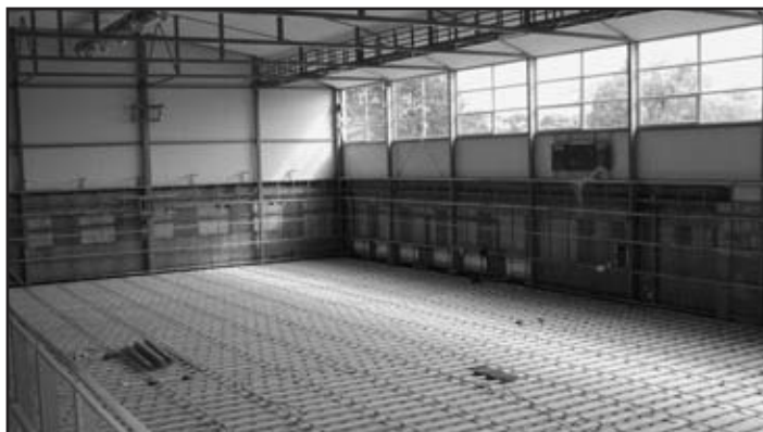
Přístavba tělocvičny k ZŠ Pražská – v měsíci květnu probíhala příprava podlahy na pokládku palubovky v nové hale Foto: MěÚ
