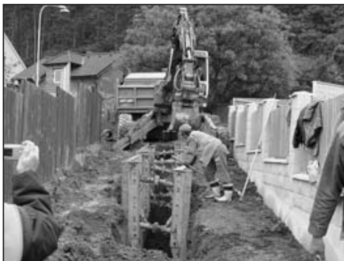
Výstavba kanalizace v ulici Pickova
