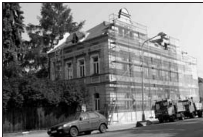
V průběhu května byly zahájeny práce na rekonstrukci fasády budovy „staré pošty“ v Pražské ulici Fota na této straně: Emilie Jeřábková
