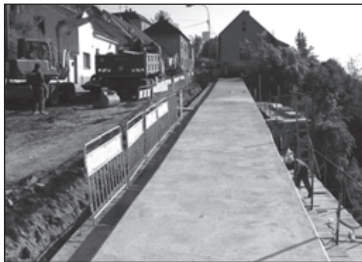
Stavba opěrné zdi v Podolecké ulici se blíží ke konci. Foto Marek Mařík
