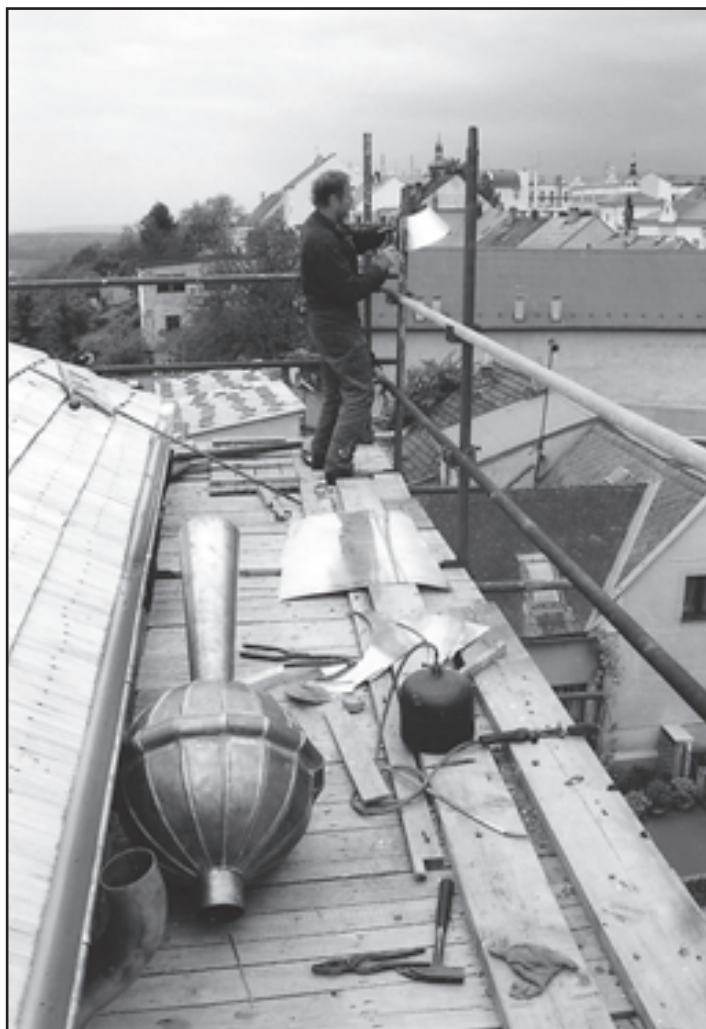
Rekonstrukce střechy na staré vodárně byla 18. května korunována úplně novou měděnou věžičkou. Jejím autorem je klempíř Ladislav Vaněk pracující pro firmu pana Frňky, kterému byla oprava vodárny zadána. Té kouli na věžičce se odborně říká makovice a k dlouholeté tradici patří ukládat právě do ní poselství příštím generacím, protože pro svou nedostupnost je tím nejlepším místem k uložení dokumentů.
