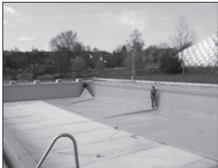
V areálu Správy sportovních zařízení se opravuje plavecký bazén.
