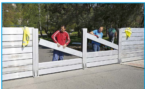
■ Výstavba hráze na křižovatce ulic Jizerní a Tovární
