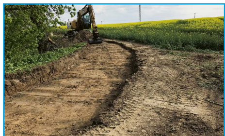
■ Zemní práce na cyklostezce Dražice
