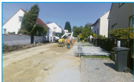
■ V ulici Kvapilova pokračují práce na pokládce vodovodního a kanalizačního řadu
