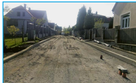
■ V ulici Čenka Prause probíhá pokládka silničních obrubníků
