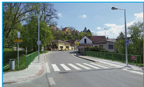
■ V březnu a dubnu byl vybudován nový přechod pro chodce v ulici Mělnická
