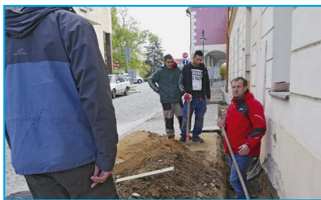
■ Příprava na izolování budovy proti vodě
