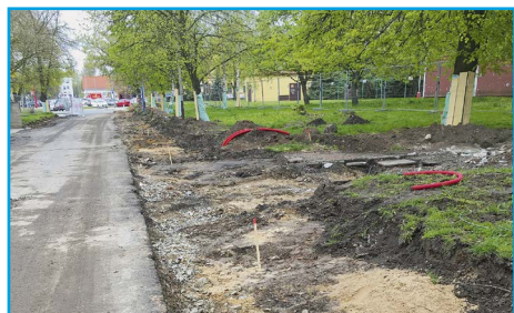
■ Rekonstrukce Platanové ulice byla zahájena
