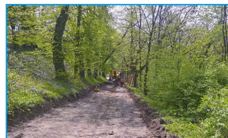
■ V dubnu byla zahájena rekonstrukce komunikace v podzámeckém parku
