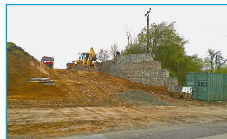
■ Pokračují práce na příjezdové komunikaci k lokalitě nad stadionem
