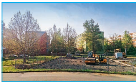
■ Víceúčelové hřiště u Billy - koncem měsíce dubna bylo zahájeno zhotovení podkladních vrstev
