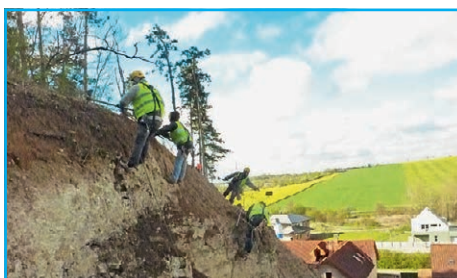
■ V horní části skály je třeba upravit sklon svahu
