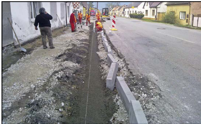
■ V průběhu měsíce dubna byly v městské části Kbel (v trase nového chodníku) prováděny práce na výměně konstrukčních vrstev nového chodníku
