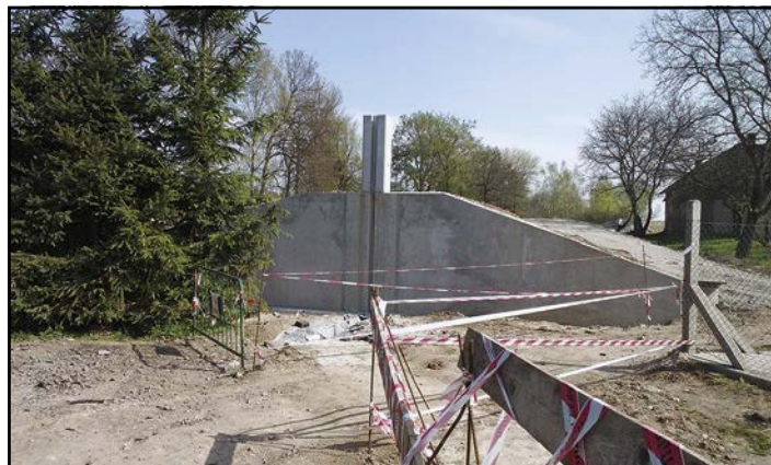
Protipovodňová ochrana města
