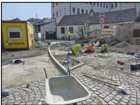
Rekonstrukce plochy u zámku a domu čp. 172 na Plajchu - dláždění zpevněné plochy
