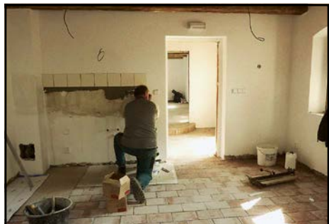
Provádění obkladů v domě čp. 172 na Plajchu
