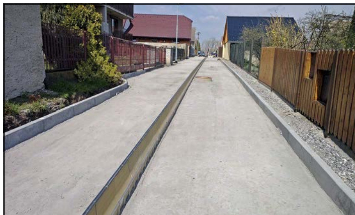
V ulici Kordinů proběhla již pokládka podkladní vrstvy z kameniva zpevněného cementem. Finální povrch byl s ohledem na velkou členitost terénu a okolních domů zvolen ze zámkové dlažby
