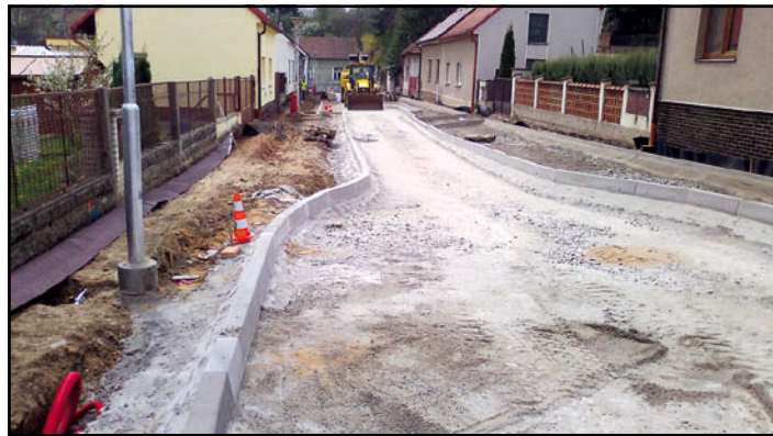
■ V ulici J. Wolкера byla v dubnu zahájena montáž nového veřejného osvětlení a rozhlasu
