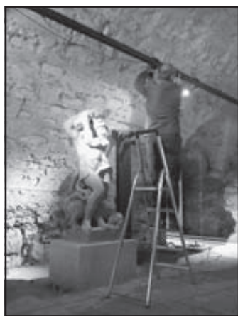
Firma GSP Benátky vyrobila a namontovala osvětlovací prvky ve výstavních prostorech a na vstupním schodišti Lapidaria MěÚ
