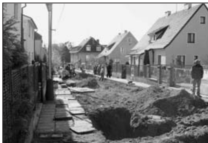
První etapa rekonstrukce Soukalovy ulice byla zahájena
