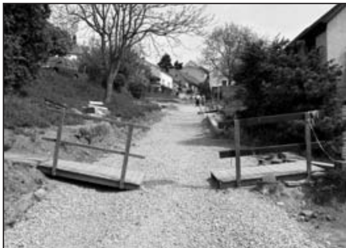
Ve Smetanově ulici pokračuje rekonstrukce komunikace – na snímku je zachycena část Smetanovy ulice v sobotu 1. května 2010
