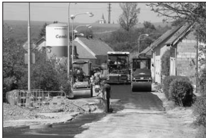
V posledním týdnu měsíce dubna probíhala v Pickově ulici pokládka asfaltového povrchu
