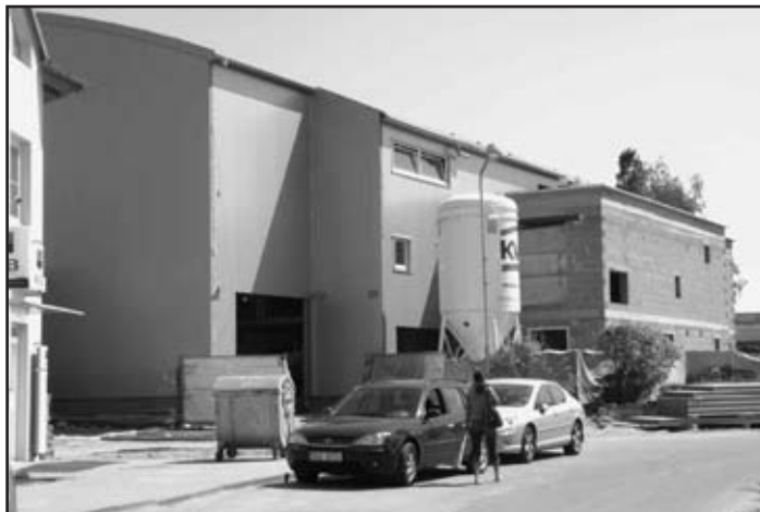
Přístavba tělocvičny k ZŠ Pražská
