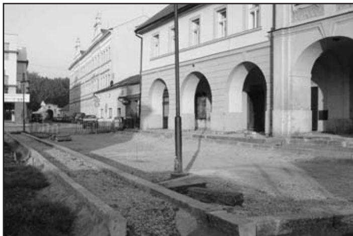
Na severní a východní straně náměstí jsou osazeny obrubníky a začíná se rovněž dláždit vozovka
