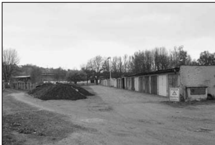
Začátkem dubna byly zahájeny práce na úpravě ploch kolem garáží za sídlištěm u bývalého ČSAD
