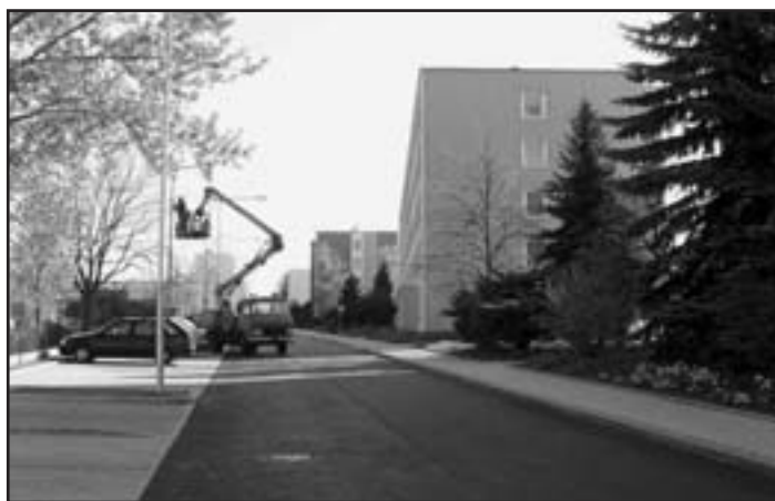
Rekonstrukce komunikace v ulici Ořechová – v průběhu měsíce dubna probíhala, kromě jiných prací, výměna stávajícího veřejného osvětlení
