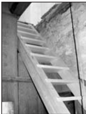
Rekonstrukce přístupového schodiště na zámekovou věž je dokončena
