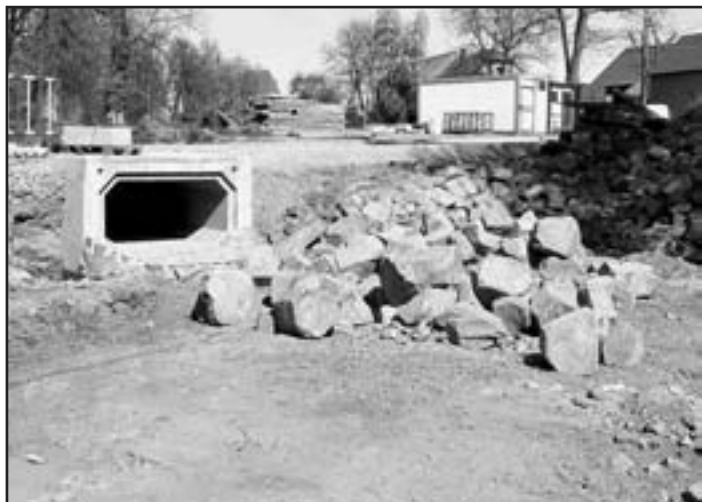
Práce na opravě komunikací po povodni jsou ukončeny.
