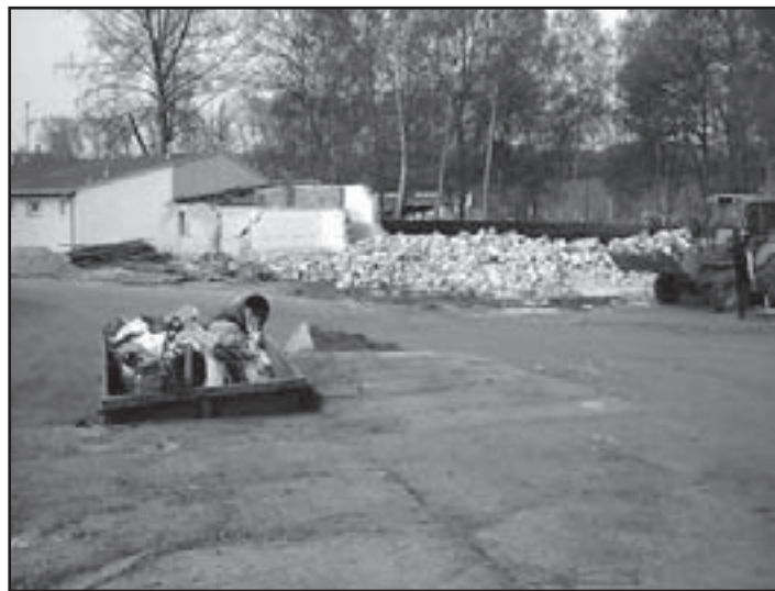
Přístavba šaten na letním stadionu začala demolicí starého objektu
