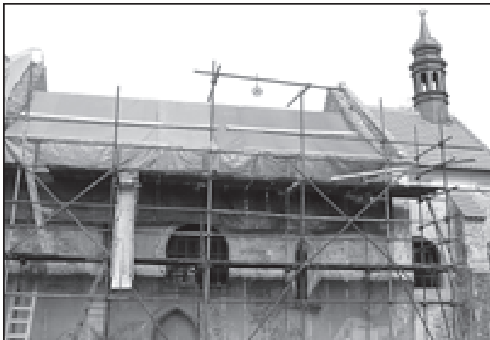
Oprava střechy dražického kostela svatého Martina
