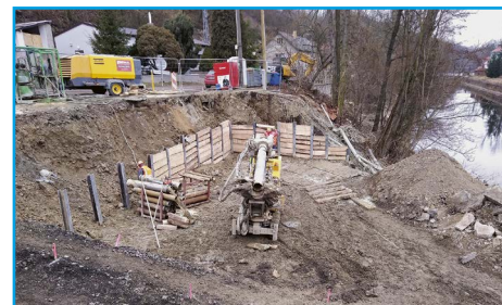
■ Realizace mikropilotáže a zpevňování základů
