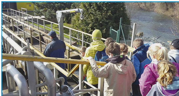
■ V čističce odpadních vod
